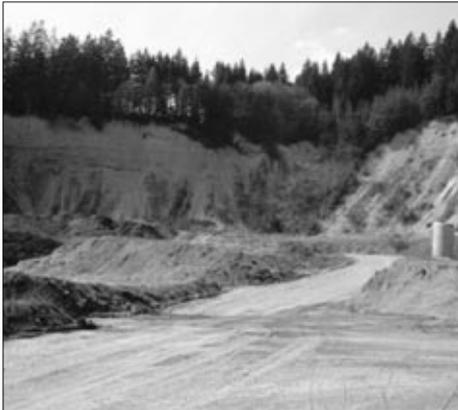
zeitig der Steilhangbereich des ehemaligen Schotterabbaus gesichert – d.h. die vorhandene Grube wird mit Bodenaushub terrassenförmig aufgefüllt.
