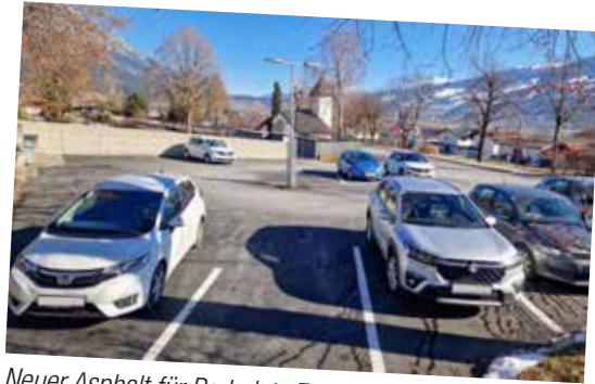
Neuer Asphalt für Parkplatz Friedhof
