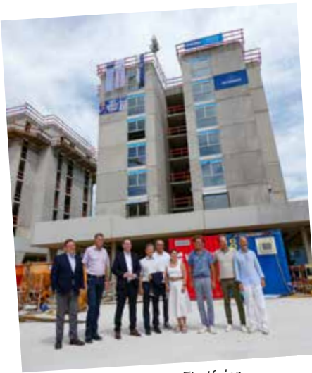
Baustelle Neue Mitte – Firstfeier
